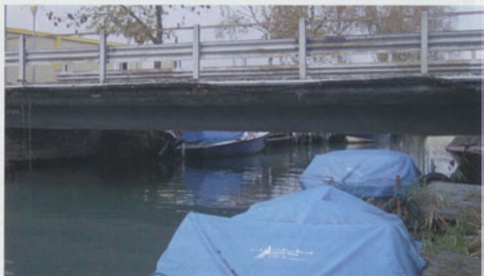
Le passage – dont le tirant d'air est d'un mètre – au-dessus du canal Stockalper sera bientôt remplacé par un pont tournant.
